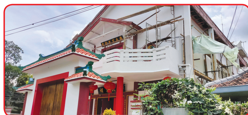
Tampak bagian depan rumah Abu Marga Yang yang sedang diperbaiki.
